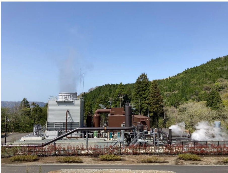
発電を行う南阿蘇湯の谷地熱発電所
