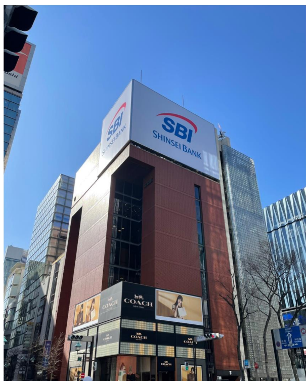
【店舗ビル外観】
