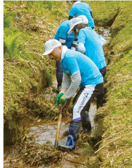
水路の泥かき作業の様子
