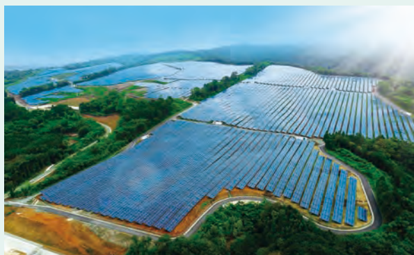
CS益城町発電所
